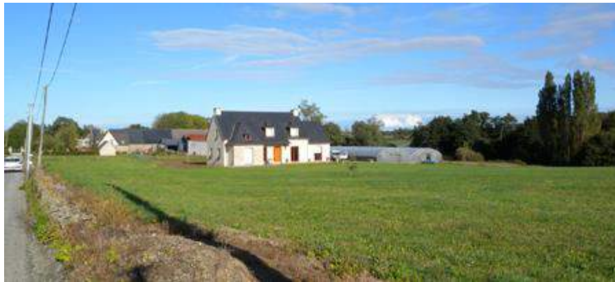
Illustration 125 : Pavillon isolé : L'effet de banalisation apporté par les pavillons péri-urbains est d'autant plus dommageable que les caractères paysagers du Clos-Poulet sont uniques. - source : Atlas des Paysages d'Ille-et-Vilaine
